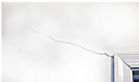
Drywall Crack
