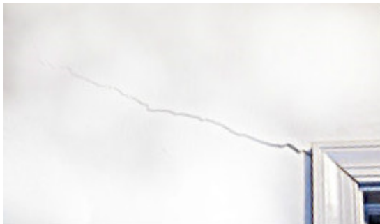
Drywall Crack
