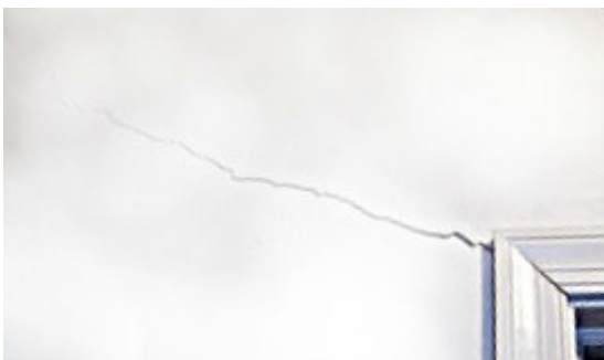
Drywall Crack
