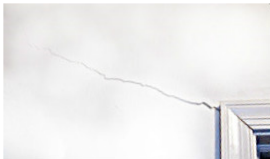
Drywall Crack
