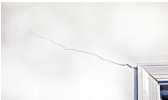
Drywall Crack
