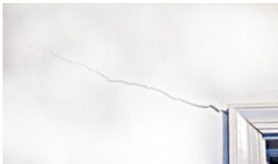
Drywall Crack
